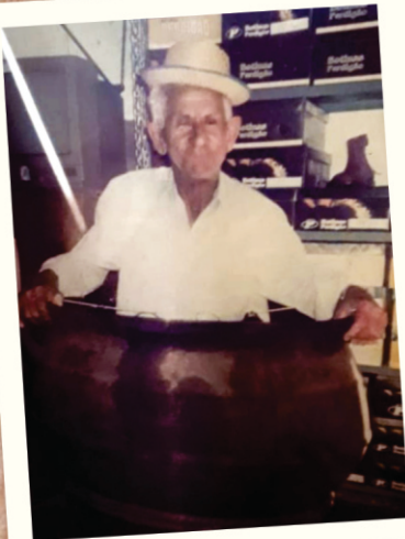
O pedreiro "GRINGA" dentro de uma panela, na loja do "Zé Preguinho". Gringa construiu e reformou casas em que Betty morou e, na sua morte, fez questão de erguer (tijolo por tijolo) a sua última morada.
